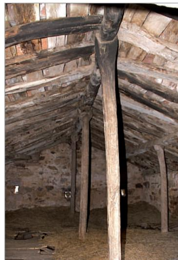
1. Una vista del interior del *h.enal* o pajar para la hierba seca, donde se muestra la característica estructura de cubierta, ya comentada en otros ejemplos. Destacan los paramentos enfoscados con mortero de arena y cal y los mechinales, que se mantienen abiertos para la aireación del heno, hermetizándolos eventualmente con paja para evitar el frío o las corrientes.
