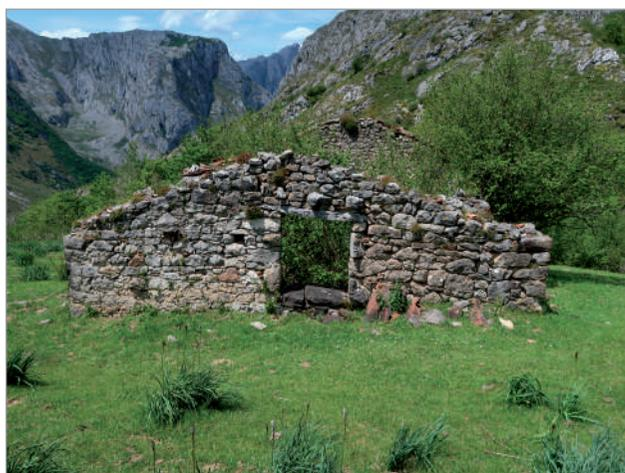
1-2. La construcción se asienta con el eje longitudinal en la dirección de la ladera, aprovechando el desnivel para procurar el acceso directo al *h.enal* desde la parte alta (2). En el hastial opuesto, orientada al noroeste, se sitúa la fachada principal con la puerta de acceso a la *corte* en posición central.
