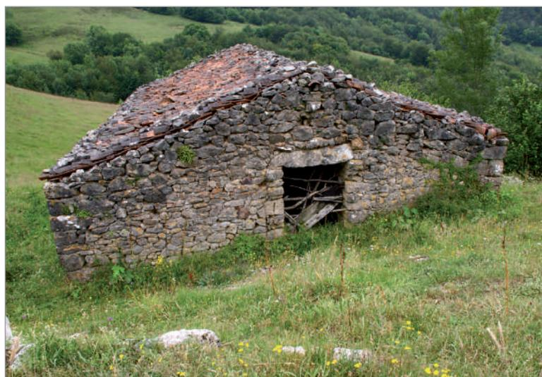
1-2. Vistas generales donde podemos apreciar —una vez más—, la claridad y sencillez en el diseño de las construcciones de la braña. En la fachada principal (2), con la puerta de la *corte* orientada al sur, se aprecia la relativa uniformidad de los mampuestos de caliza del *huriu*, que se interrumpe en la esquina con la inclusión de bloques de mayor tamaño, cuya trabazón con el resto del muro no llegó a conseguirse comprometiendo la estabilidad del conjunto.
