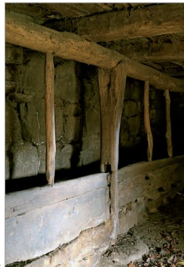
1. Detalle del *payar* mostrando la estructura de la cubierta: la viga de cumbre cuenta con los hastiales como elementos resistentes, reforzando su luz con un doble *peruyu* o puntal apoyado en el tirante central. Sobre éste mismo, otro *peruyu* rematado en *forquetu* (ahorquillado) sirve de apoyo al *cumbraliyo* o terciá.
