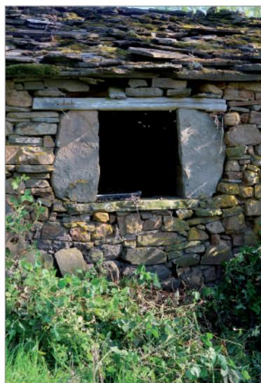
1. Vista desde el lado norte, que muestra la existencia —insólita en las construcciones de esta braña— de dos *bocarones*: uno en el hastial posterior y otro en el muro lateral. Se colocan a distintas alturas para conseguir el máximo de carga en el *payar*.
