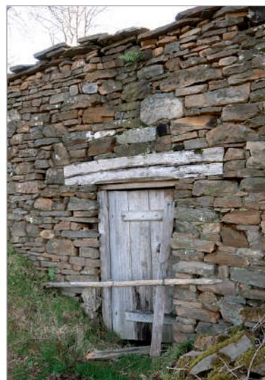
1-2. Dos vistas de la construcción, con el acceso principal al *esteblu* a través de una puerta de *cabiyón* en el hastial sur .
